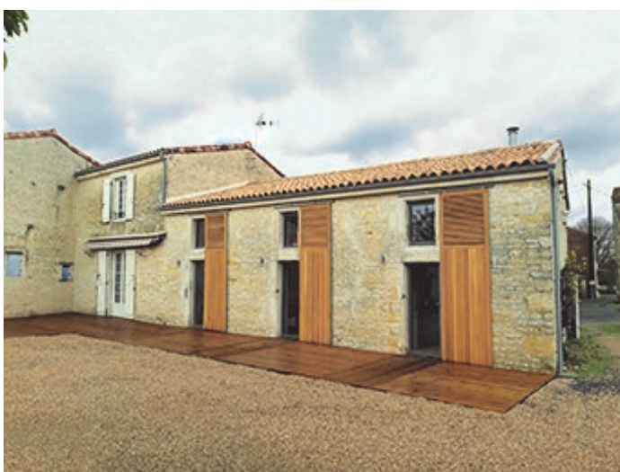
Cette rénovation à Usseau, Val-de-Mignon (79), combine le dessin moderne des volets toute hauteur coulissants, habillant des ouvertures modifiées en reprenant rythme et dimensions traditionnels Architecte : Sylvie Mimbré
